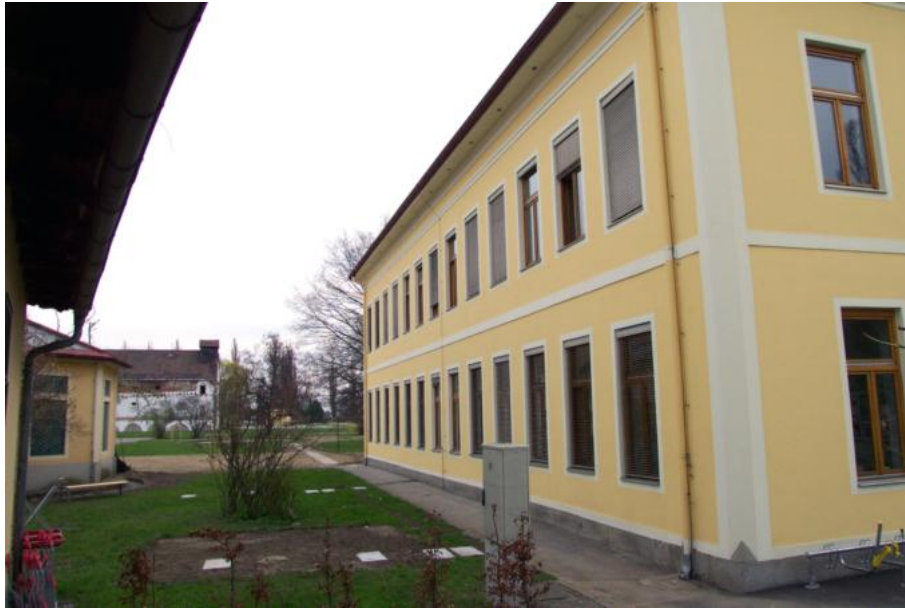
Abb. 5: Ostseite des Gebäudes
