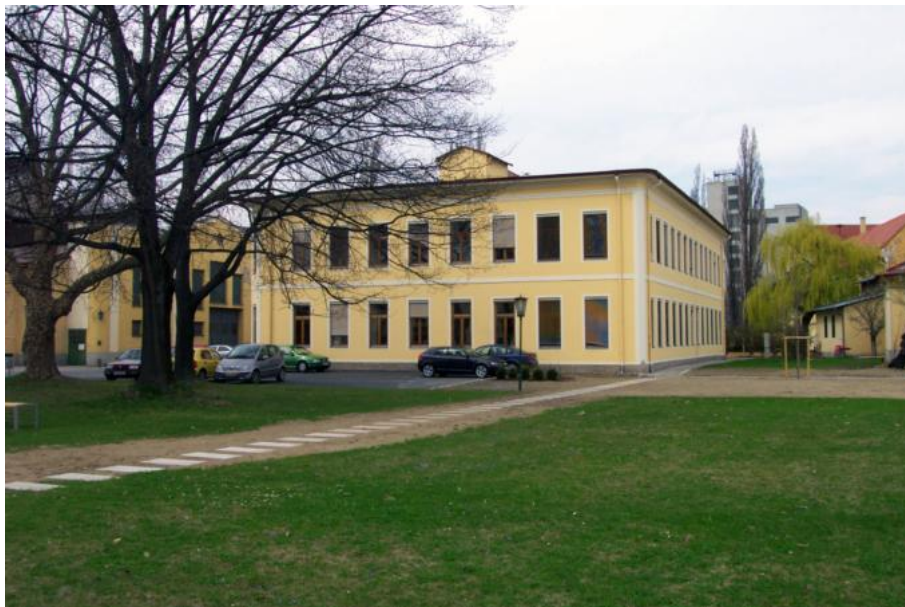
Abb. 4: Südseite des Gebäudes
